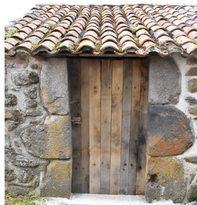
Rénovation de la porte du four d'Alloux
