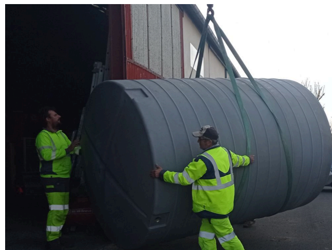
Mise en place d'un récupérateur d'eau de pluie
