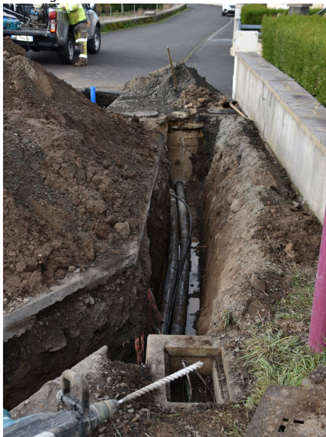
Réparation et détection des fuites
