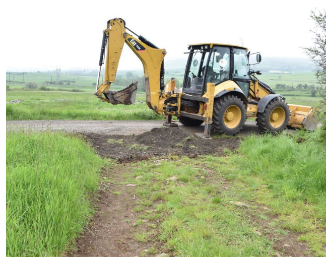
Préparation des fossés
